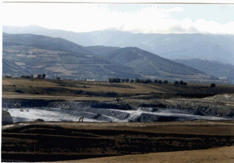
FOTO 5.3.- BANQUEOS INICIALES DE LA EXPLOTACION DE BELORADO. ETAPA DE RETIRADA DE LOS PRIMEROS NIVELES DE RECUBRIMIENTO
